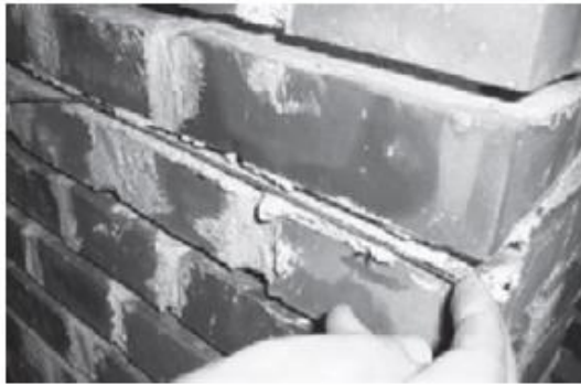
Şekil 2. LP (CFRP) Şerit ile Duvar çekme dayanımını artıracak şekilde güçlendirme [8]
